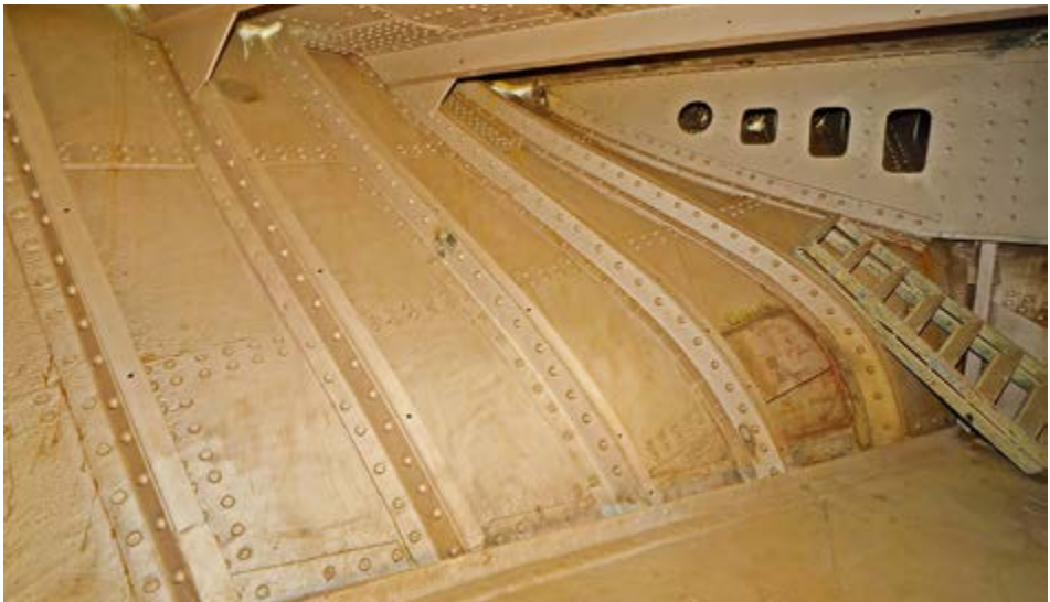
Spanten und genietete Außenhaut im Heck des Schiffes auf Zwischendecksniveau
