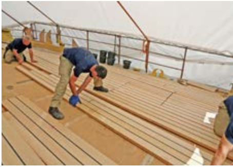
Präzise vorgefertigte Decksplankenelemente werden auf dem Backdeck verlegt
