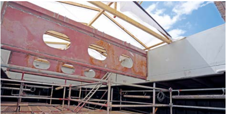
Arbeiten an der Luke 2
